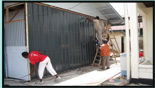
Renovatie van het minitheater.
